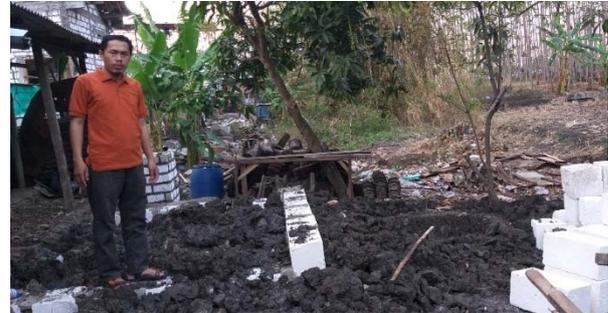
Gambar 2 Pembuatan Bak Pengolah Limbah Pewarna
