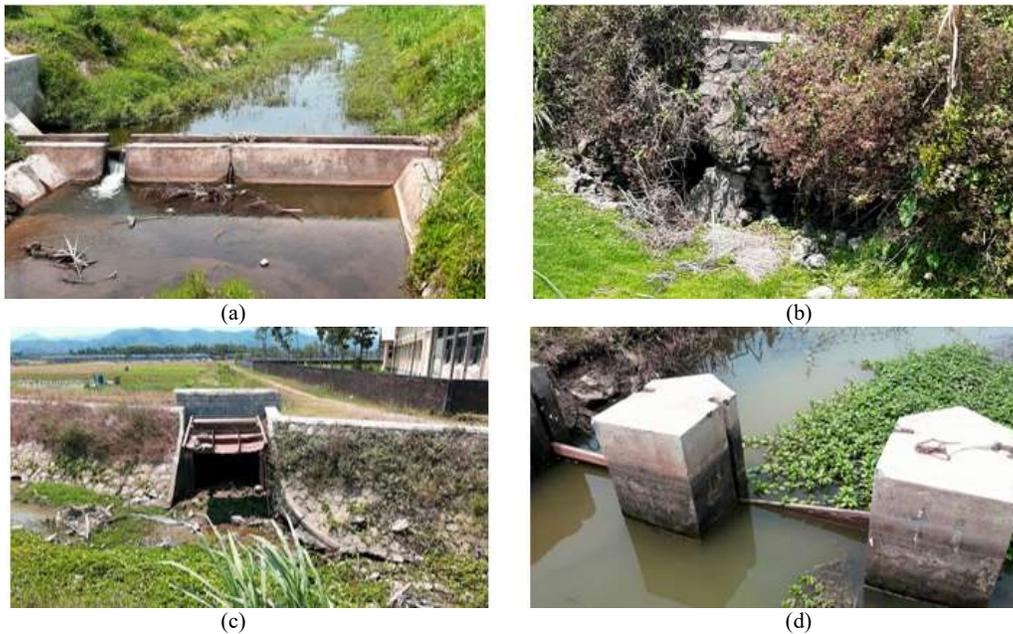
Gambar 5. Kondisi bangunan air di saluran drainase Kawasan Aerotropolis YIA; (a) *Groundsill* di saluran Carik Timur; (b) Penyumbatan di pertemuan saluran Carik Timur-Ledeng; (c) Kondisi pintu air di saluran Kaligintung; (d) Kondisi pintu air di saluran Jelantoro
